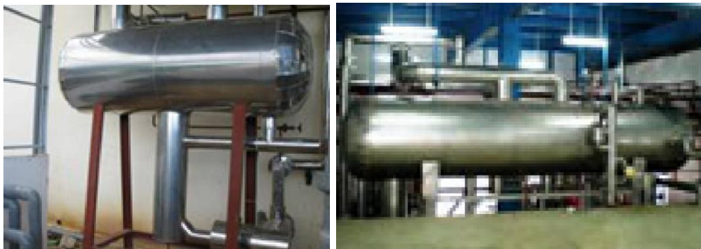
Hình 2.64: Bình chứa hạ áp
