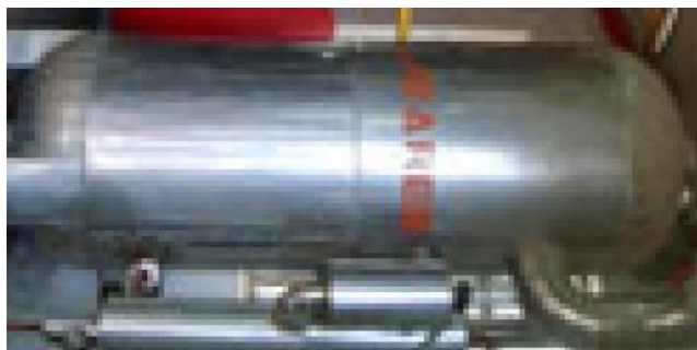
Hình 2.69: Bình trung gian nằm ngang
